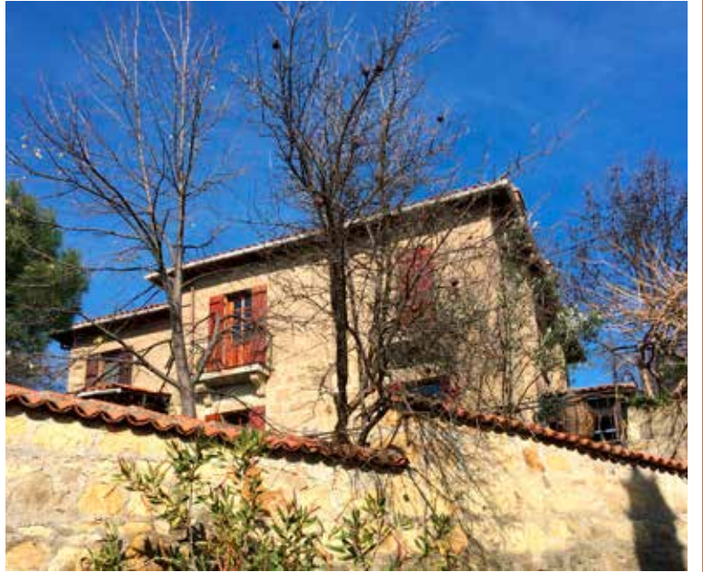
Üstte, Adatepe'nin karakteristik binaları düğün fotoğrafı çektiren çiftlerin rağbet ettiği çekim noktalarından. Altta, Günümüzde Adatepe'deki sivil mimari doku büyük ölçüde restore edilmiş durumda.
